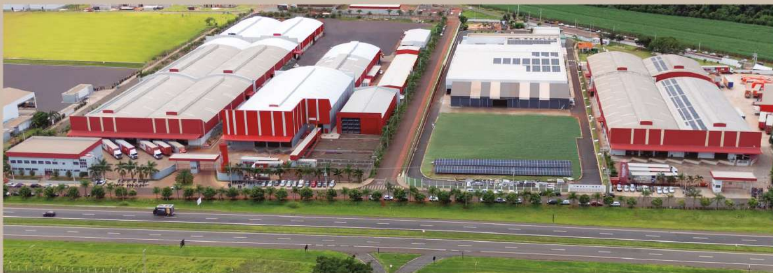
Unidade Colchões - Espuma - Sofá - Aguaí - SP
